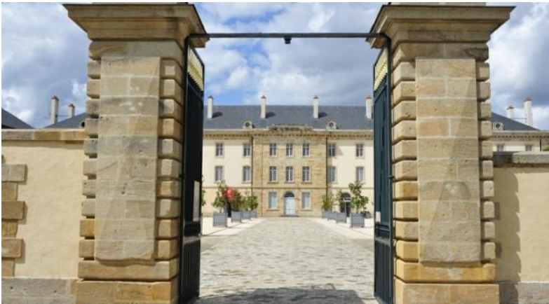
Façade du Centre National du Costume de Scène en rive gauche (source site internet CNCS)
