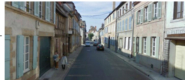
Exemple d'urbanisation des faubourgs sur la rue de Bourgogne
