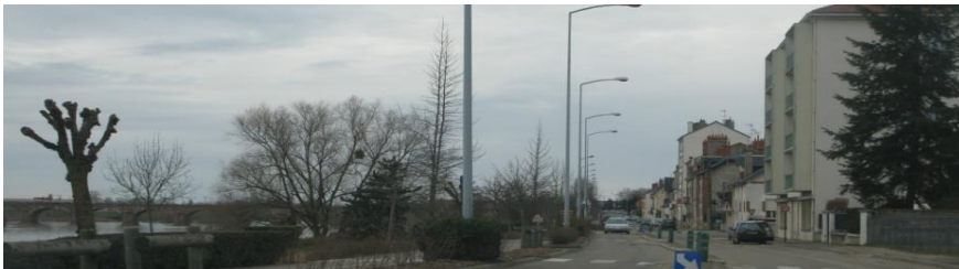
Des bâtiments plus récents en R+5, à côté de bâtiments anciens en R+1/R+2 donnent une silhouette irrégulière
