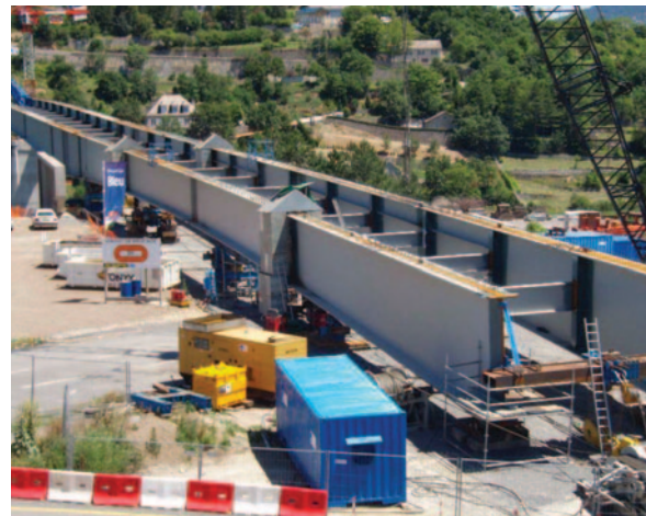
Vue d'ensemble d'une plateforme d'assemblage (©Bouygues TPRF)
