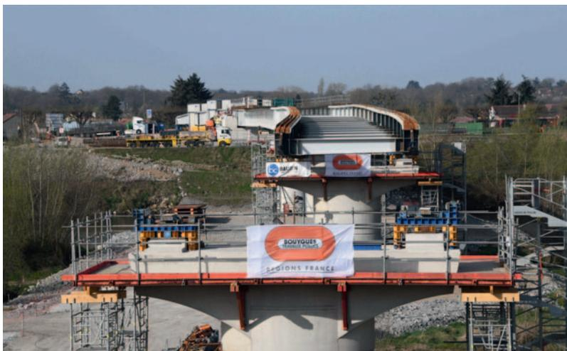
pile (P1) puis sur la deuxième (P2) et la troisième (P3). L'opération devra être renouvelée une dernière fois pour faire passer la totalité de la charpente, sur laquelle va ensuite être construit le tablier. En rive droite, un gigantesque échafaudage est en cours de construction autour des appuis qui
