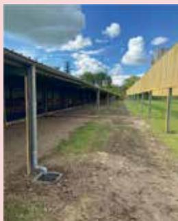
Enfin, au stand des 50 mètres, sept puisards ont été réalisés au pied des descentes des eaux pluviales afin d'éviter le ruissellement et la stagnation des eaux de pluie.
